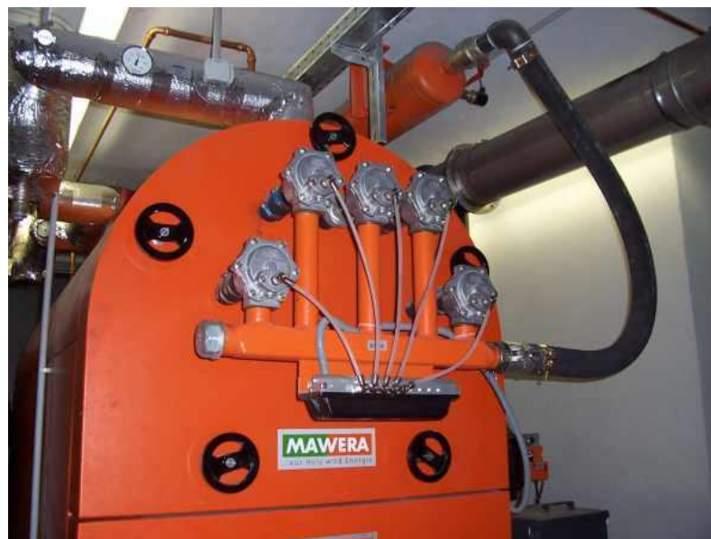
Pneumatyczne czyszczenie płomieniówek
