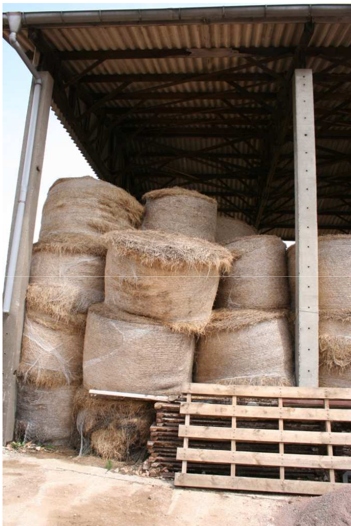
KOTŁOWNIA NA BAŁE ZE SŁOMY W SZKOLE W WINSKU O MOCY 1000 kW
