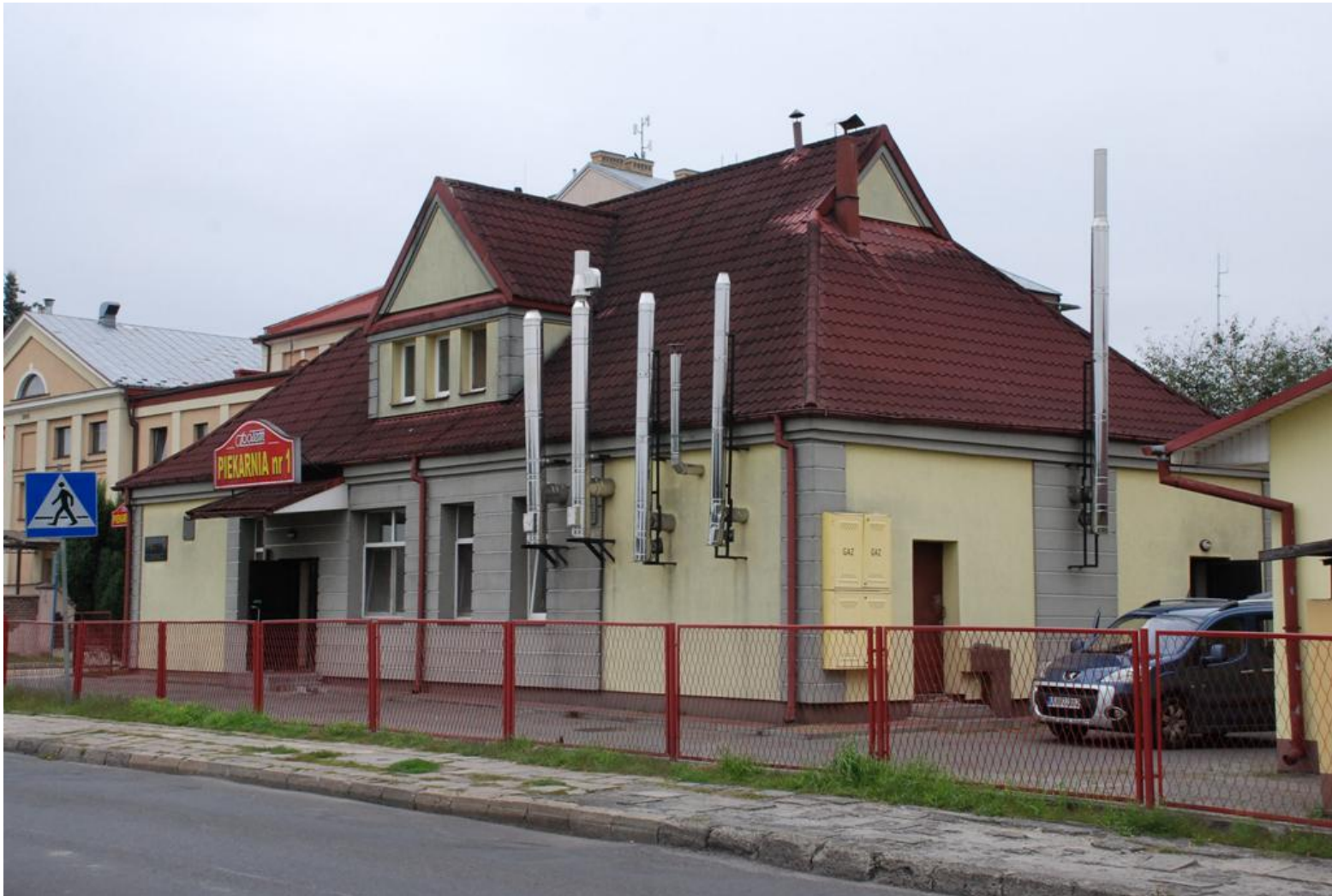
Negatywny przykłady montażu urządzeń technicznych w budynkach zabytkowych, Zamość
