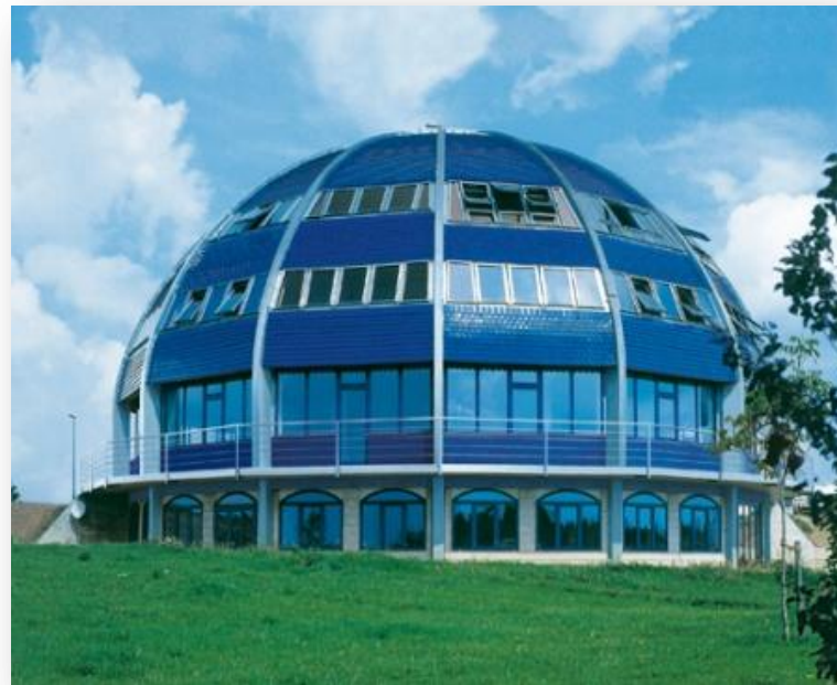
Budynek usługowy w Niemczech
