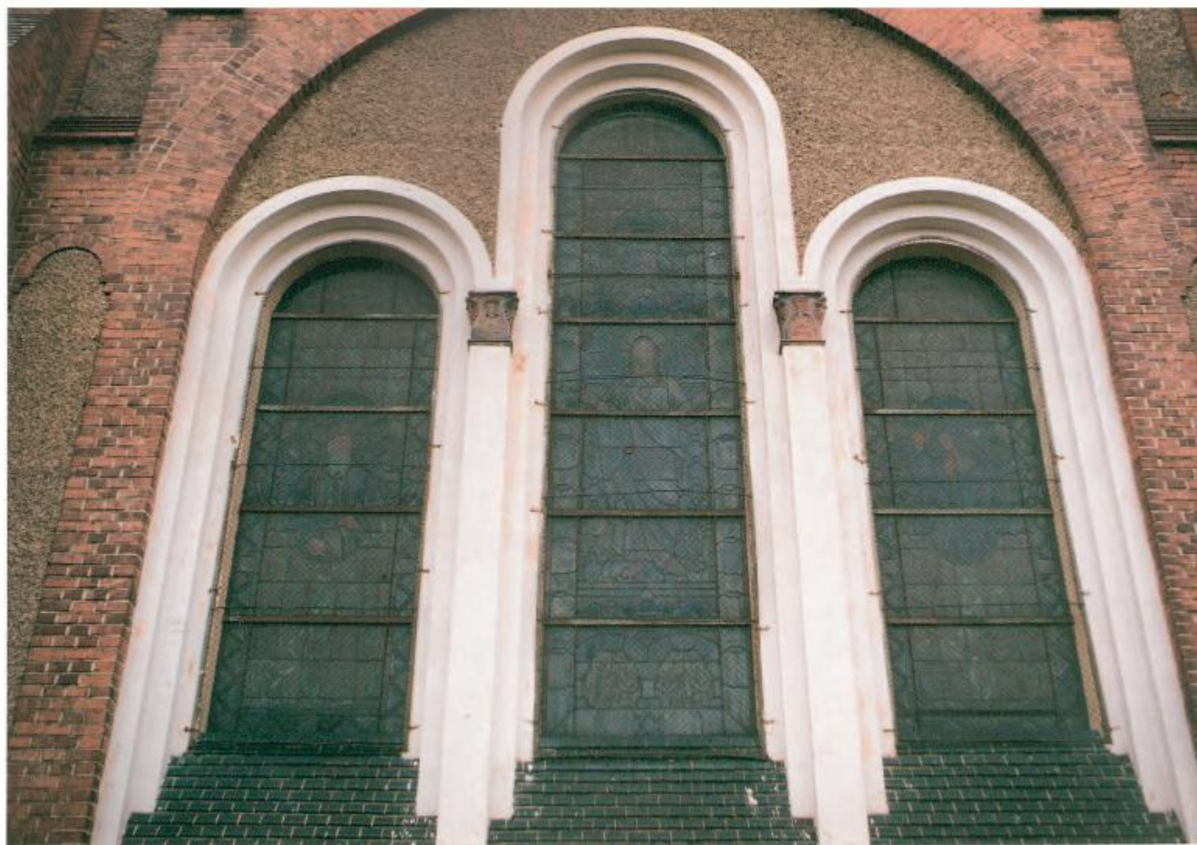
Fot.2. Witraże tarnseptu południowego : okna SIV, SV, SVI; kośc. p.w.Św. Jakuba Apostoła w Ścinawce Dolnej. Stan przed konserwacją. Widok od zewnątrz.
