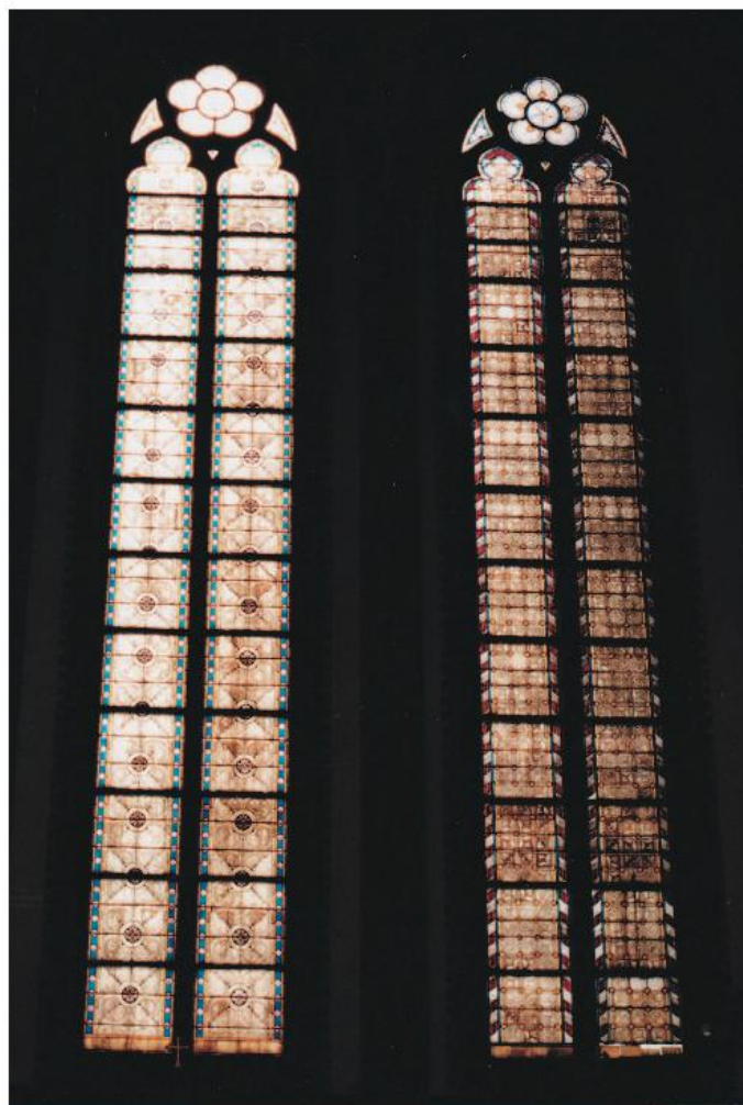
Fot.1. Widok od wewnątrz okien n XI i nX z nawy północnej kościoła p.w. Św. Aniołów Stróżów w Wałbrzychu. Stan zachowania luty 2013
