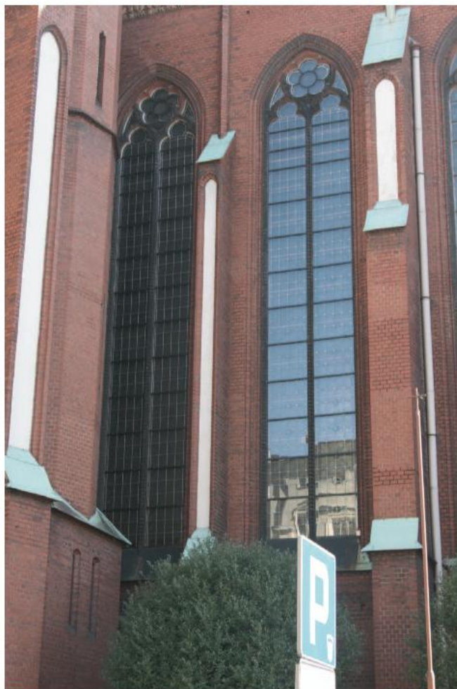
Fot.424. Okna nX i nXI po konserwacji, widok od zewnątrz, stan z września 2013
