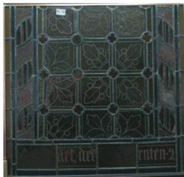
Fot.12-14. Kwaterna nX 1b, stan zachowania po konserwacji. Zdjęcia wykonano w świetle przechodzącym strona wewnętrzna, w świetle odbitym strona wewnętrzna, w świetle przechodzącym strona zewnętrzna.
