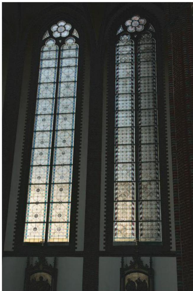
Fot.423. Okna nX i nXI po konserwacji, widok od wewnątrz, stan z września 2013
