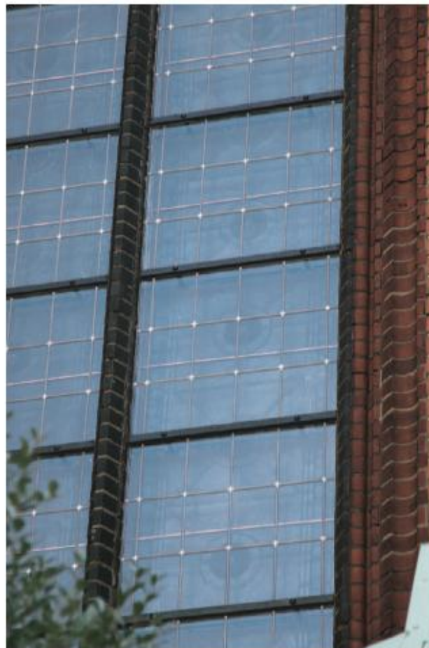
Fot.432-433. Okna nX i nXI po konserwacji, widok od zewnątrz, fragmenty oszkleń ochronnych. Stan z września 2013
