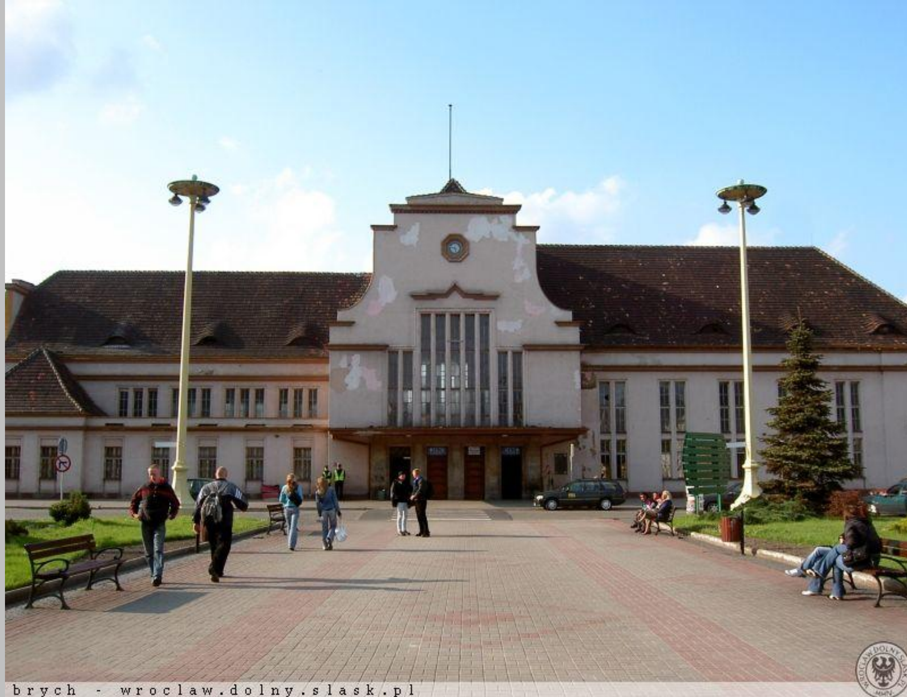
Legnica, tzw. Nowy Dworzec, stan przed remontem
