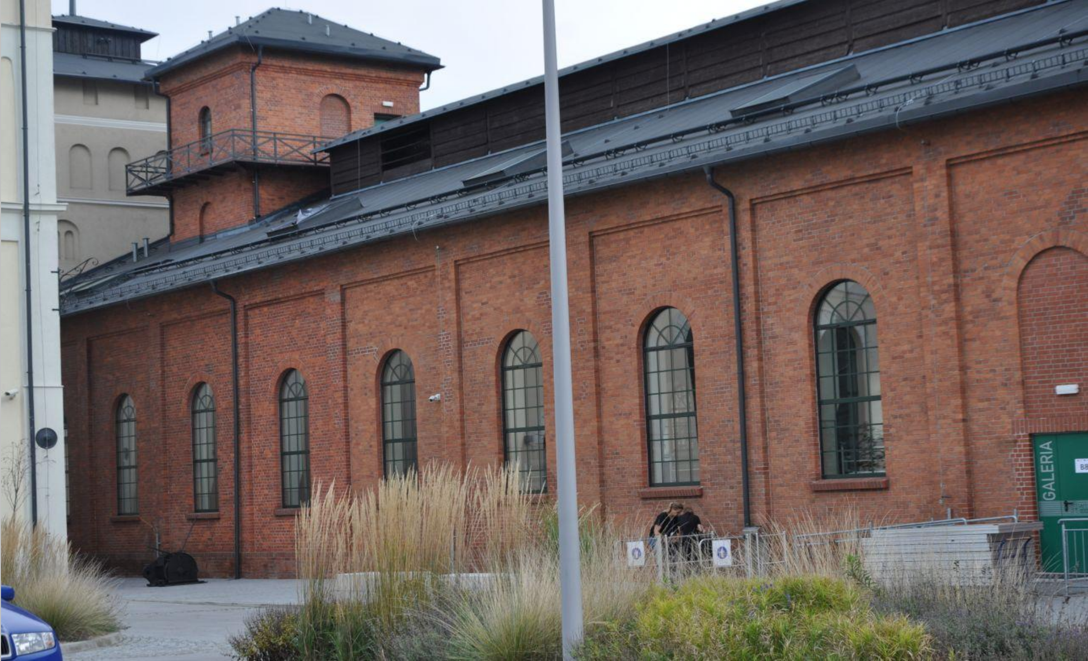
Wałbrzych, dawna Siłownia w KWK Julia, obecnie Centrum Nauki i Sztuki Stara Kopalnia, stan po remoncie
