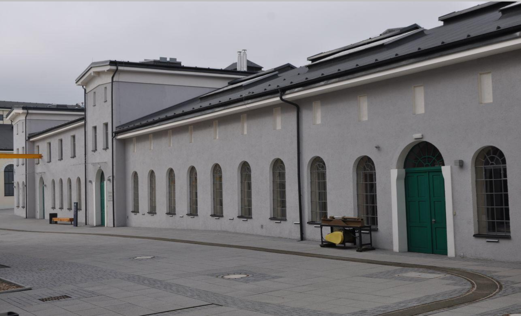
Wałbrzych, dawna kuźnia w KWK Julia, obecnie Centrum Nauki i Sztuki Stara Kopalnia, stan po remoncie
