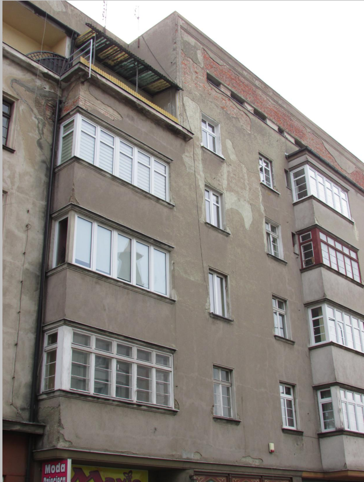
Legnica, ul. Dziennikarska 11, dawny tzw. „Elfmannbau” 1930-1931, stan obecny
