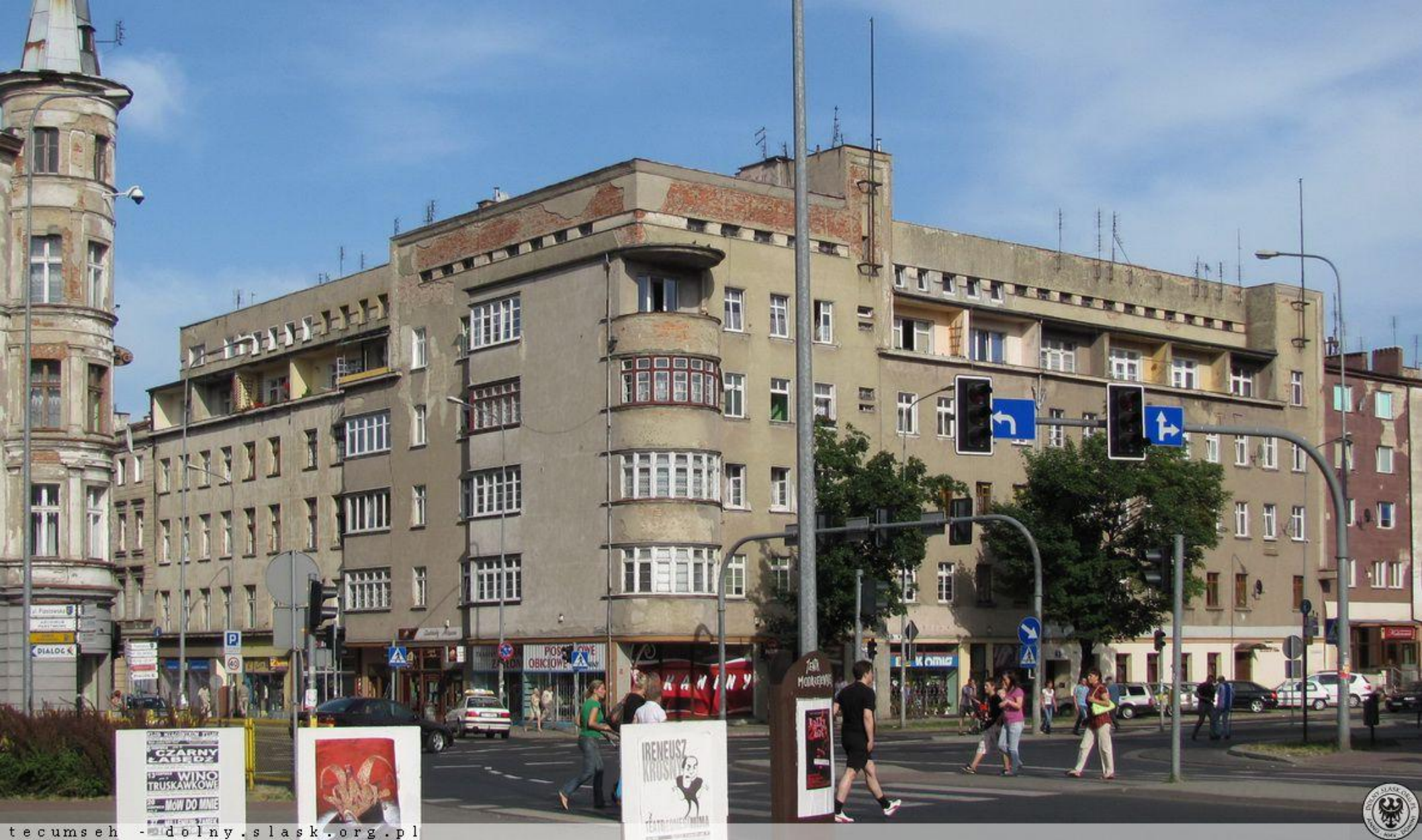
Legnica, ul. Dziennikarska 11, dawny tzw. „Elfmannbau” 1930-1931, stan obecny
