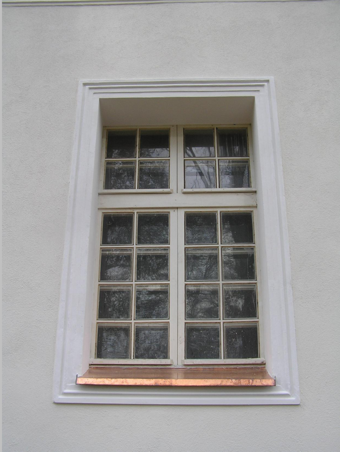
Duża Wólka, dwór renesansowy, 1570, stan stolarki po remoncie
