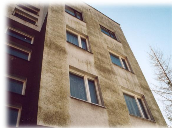
Skażenie mikrobiologiczne na elewacjach
