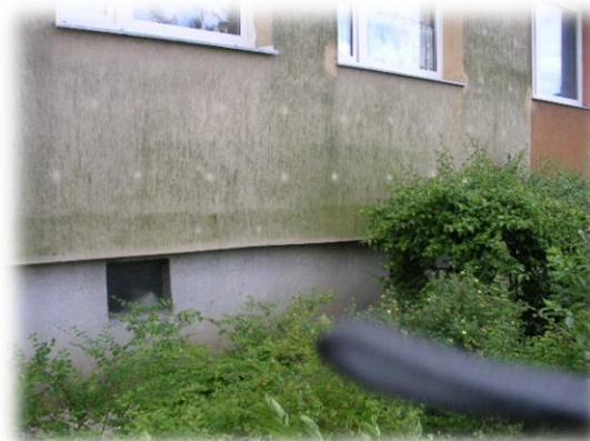
Skażenie mikrobiologiczne na elewacjach
