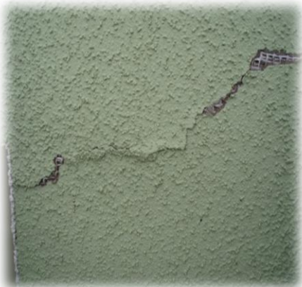
Pękanie i osypywanie się warstw zewnętrznych ocieplenia
