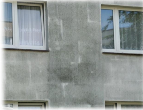
Nieprawidłowe połączenia ocieplenia z innymi elementami budynku
