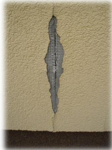
Pękanie i osypywanie się warstw zewnętrznych ocieplenia
