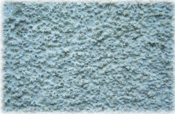
Pękanie i osypywanie się warstw zewnętrznych ocieplenia
