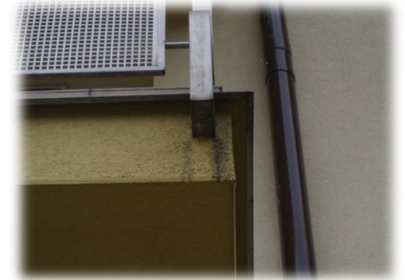
Nieprawidłowe połączenia ocieplenia z innymi elementami budynku
