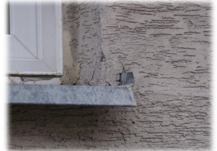
Nieprawidłowe połączenia ocieplenia z innymi elementami budynku
