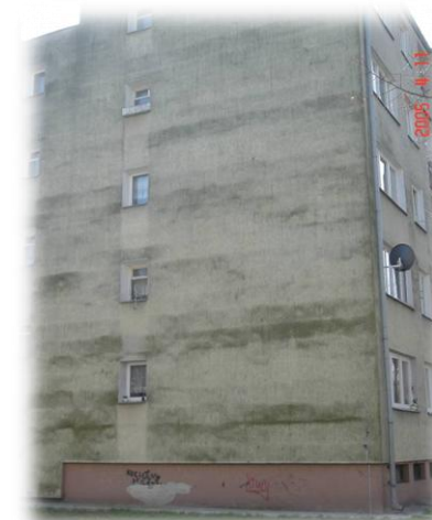
Skażenie mikrobiologiczne na elewacjach
