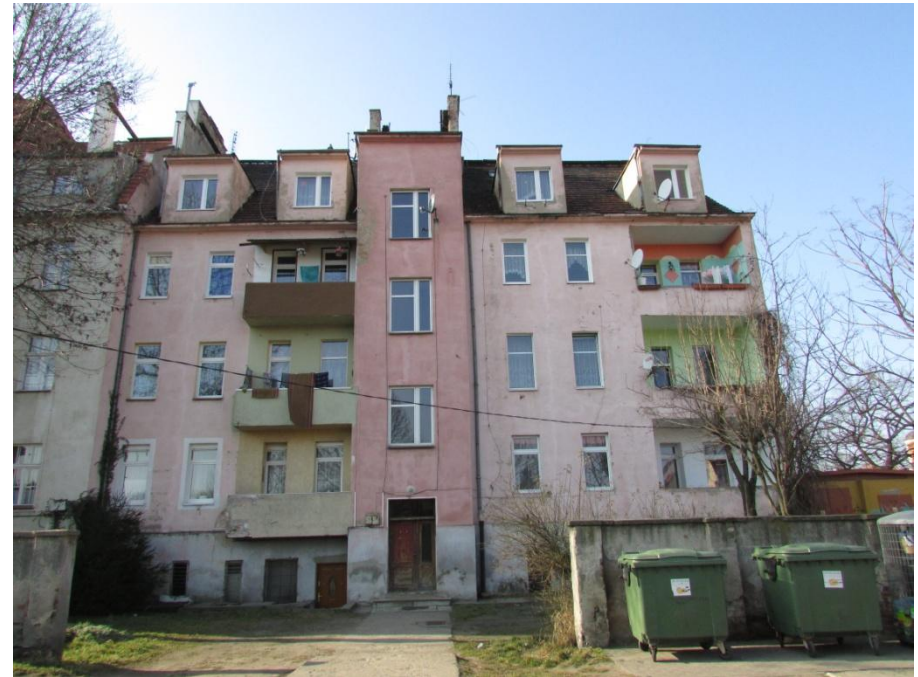
Elewacja tylna, ul. Staromiejska 13
