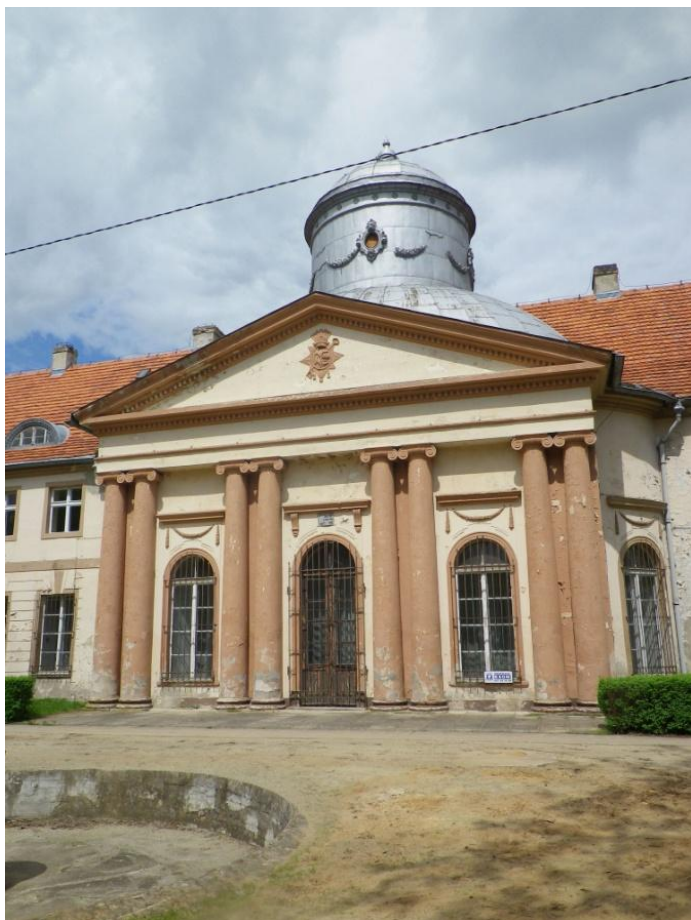
Elewacja południowa przed remontem
