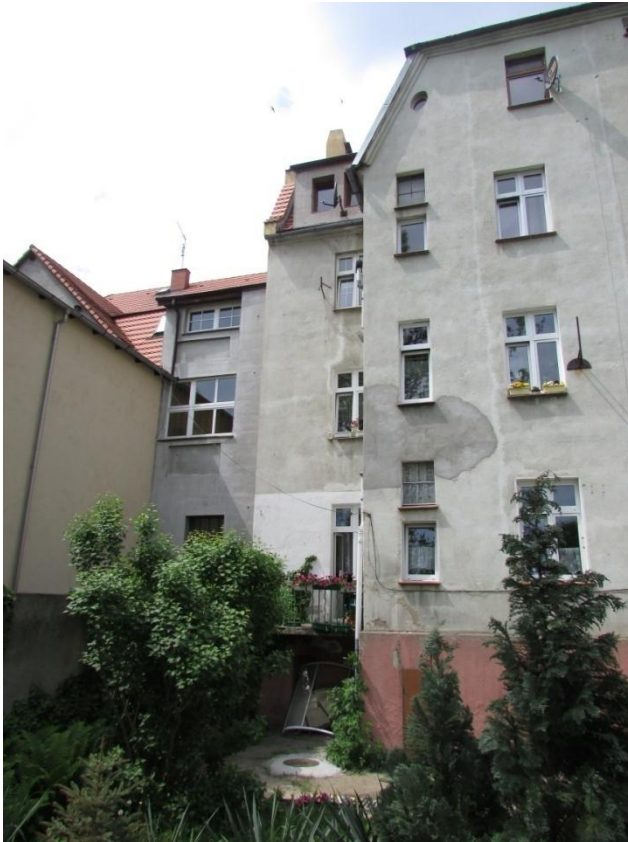
Fragment elewacji tylnej, ul. Staromiejska 15
