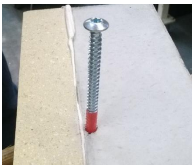
Beton, MW-Abstand < 5 mm
