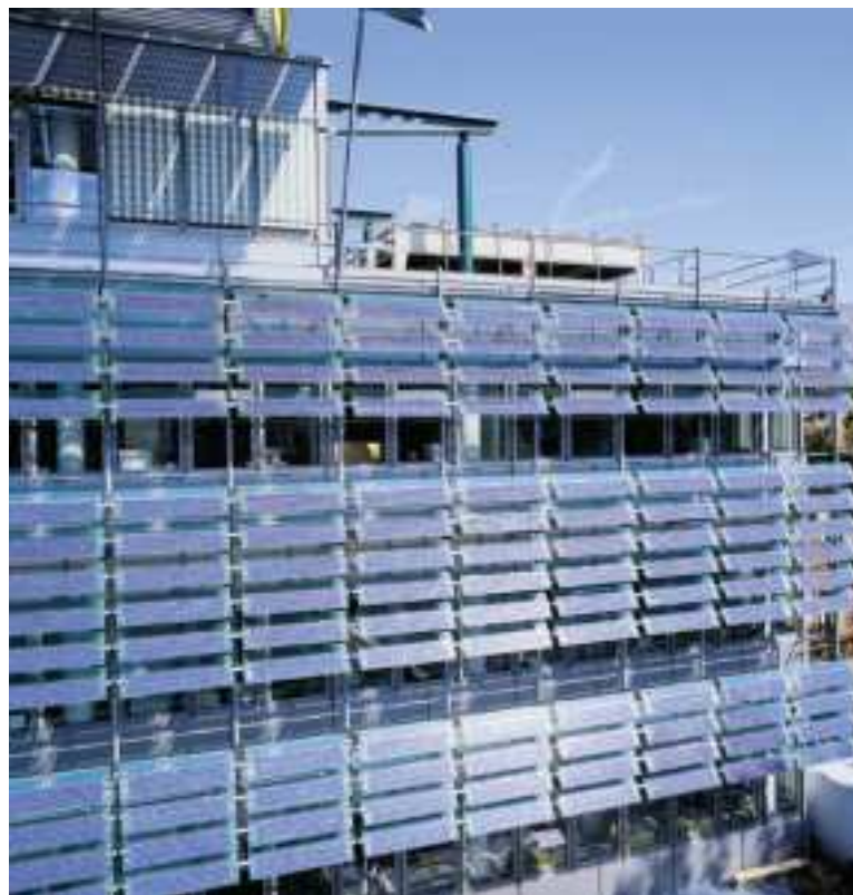
Fasada paneli słonecznych Uniwersytet w Erlangen (D)
