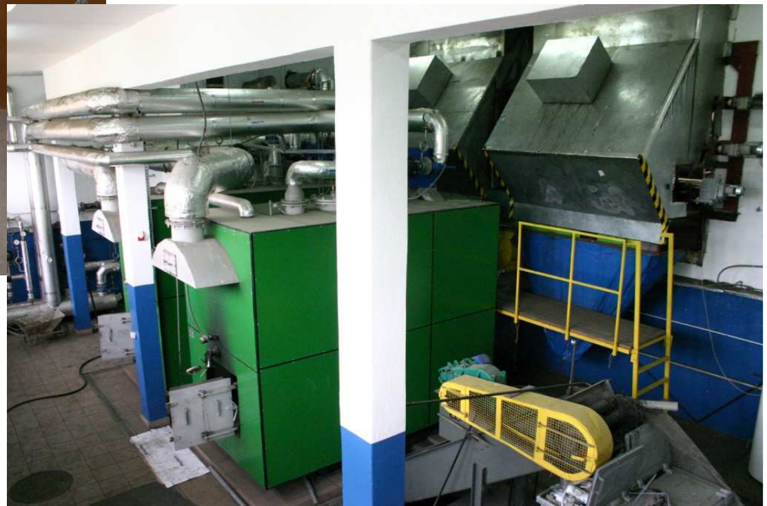
KOTŁOWNIA Z AUTOMATYCZNYM PODAJNIKIEM NA SŁOMĘ W SZKOLE W ŚCINAWIE O MOCY 1800 kW
