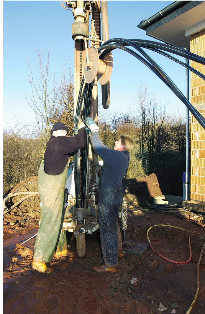
Przygotowanie dolnego źródła ciepła dla gruntowej pompy ciepła
