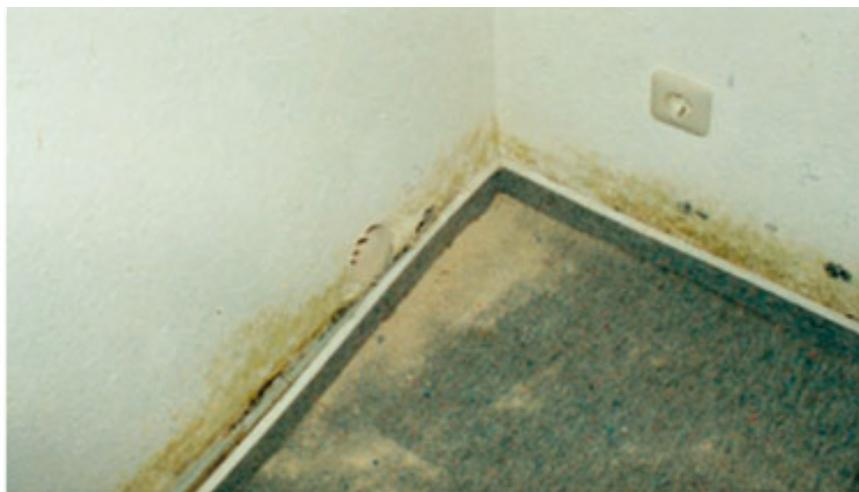
Feuchteschäden im Sockelbereich durch Kondensatbildung
