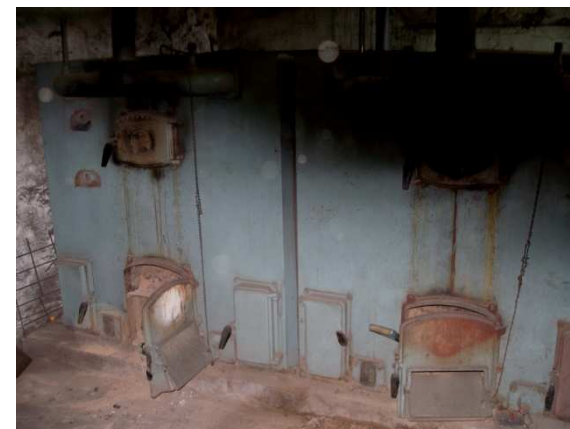
Kotłownia - stan przed modernizacją
