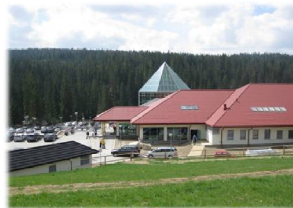
Geotermia w Bukowinie Tatrzańskiej Woda termalna z odwiertu jest przesyłana do obiektów rurą preizolowaną Flexalen FVR200A125 2007 rok
