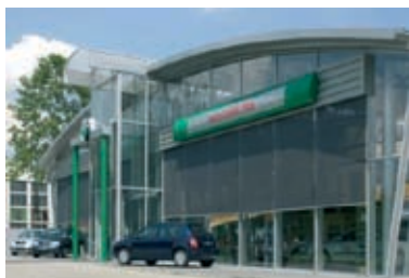
Zastosowanie zewnętrznych osłon przeciwsłonecznych (refleksol) (SELT)
